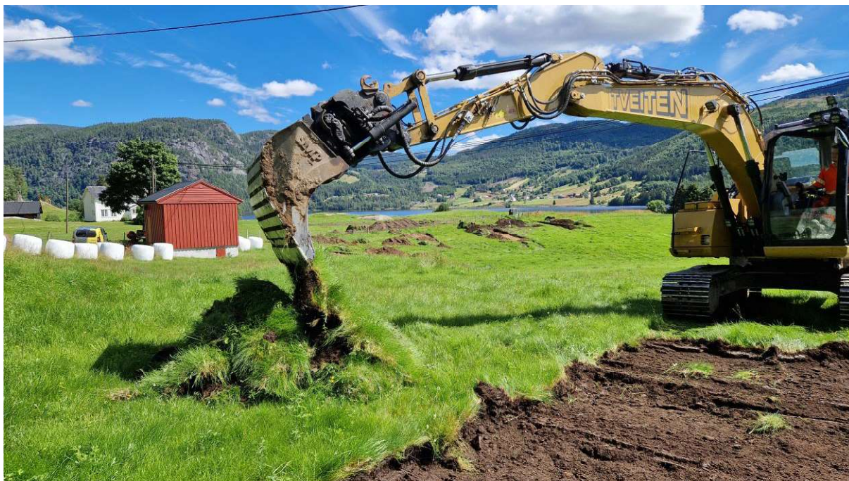
Figur 13. Arbeidsbilette frå sjaktinga. Sett mot aust-nord aust.
