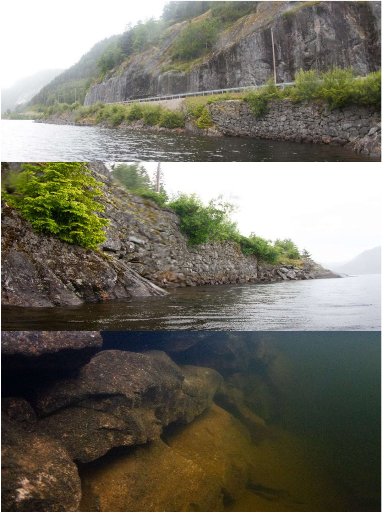
Figur 8. Bilder over og under vann av den gamle veiforbygning ved profil ca. 6000.
