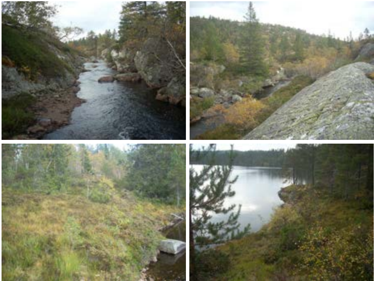
Figur 2: Øvre bilder viser sted for planlagte inntak rett nedstrøms utløpet fra Osphomtjønn. Bildene under viser planlagt stasjonstomt med utløp i Sandvatn. Fotos: Ole Roer.
